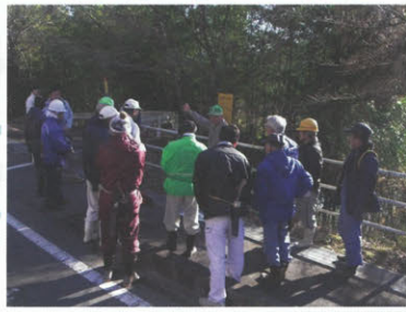
▲作業は朝早くから始められます。
