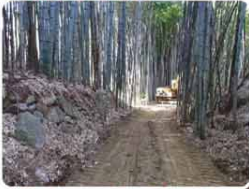
▲軽トラックが通行できる管理用通路ができました！
