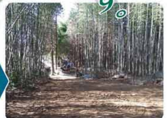
▲伐採後、広い進入路の入口ができました。
