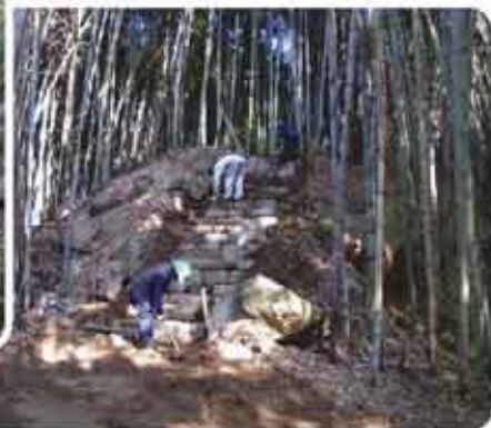
▲急な勾配のところは、石を用いた階段で通路をつなげます。
